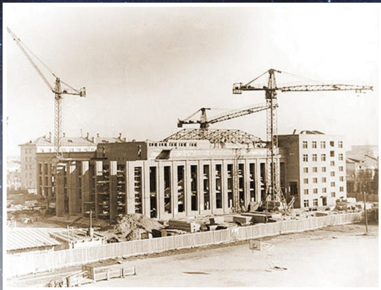
Строительство наукограда Королев
